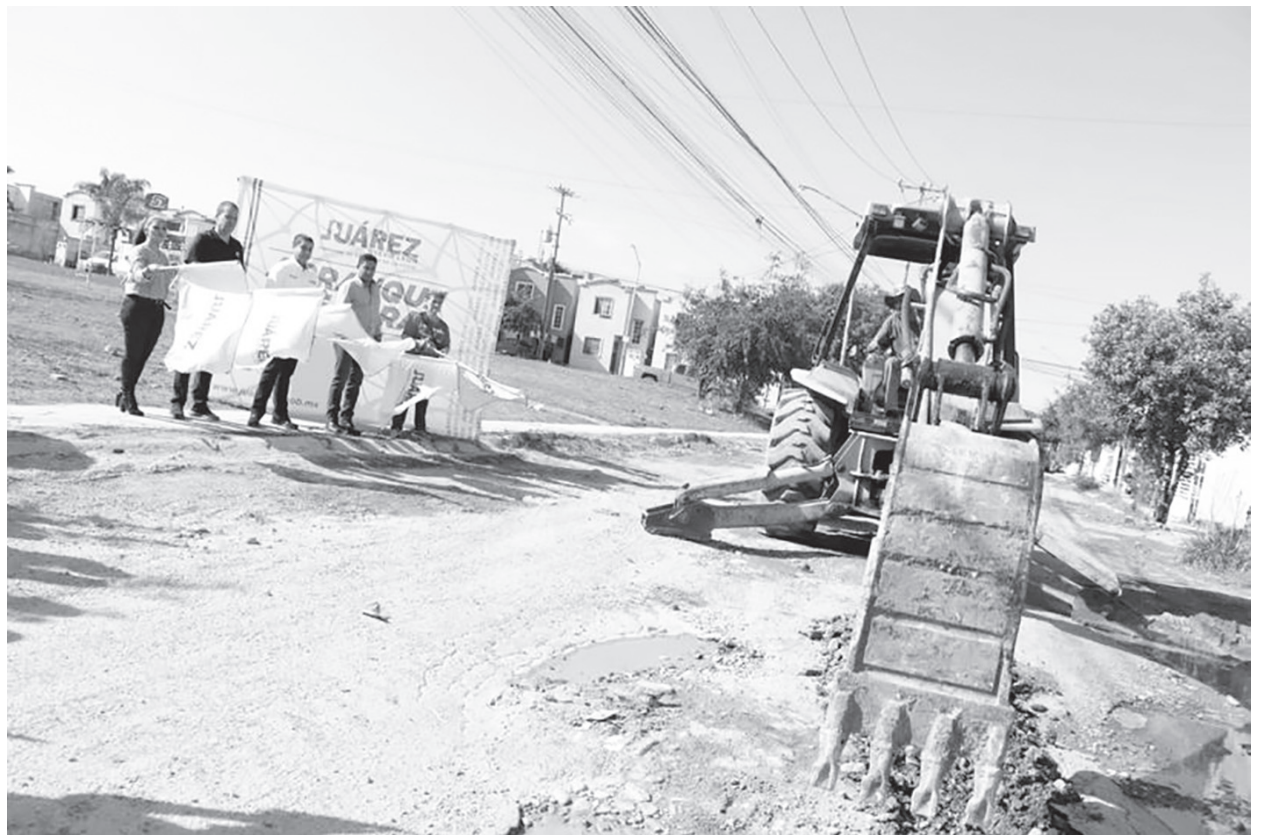
Banderazo con el que se inició la repavimentación de la calle San Fernando.
